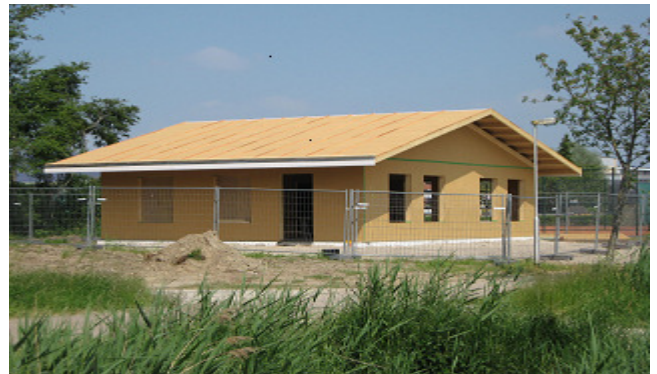
Inzwischen ist der Jugendtreff im Bau
